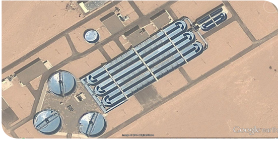
شكل 5. خندق الأكسدة في محطة ينبع لمعالجة مياه الصرف الصحي 60000م 3 /يوم
