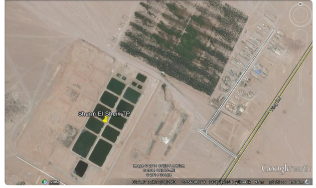
شكل 7. أحواض محطة شرم الشيخ
