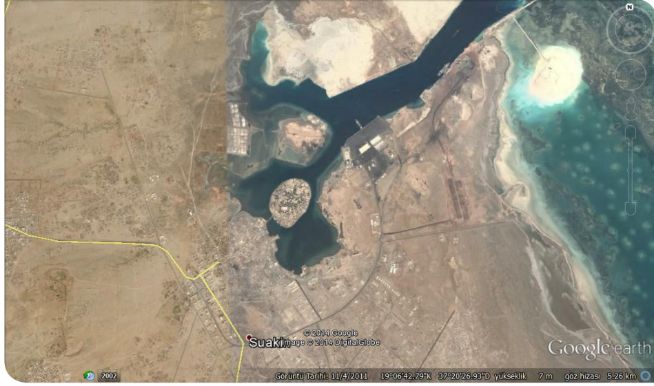
شكل 18. أحواض الصرف الصحي بمدينة سواكن التي قد تتسرب إلى البحر الأحمر
