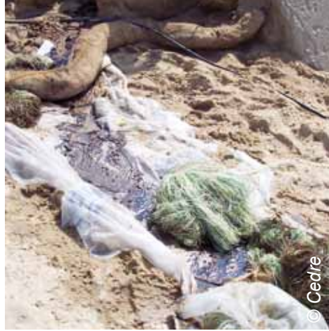
حواجز احتواء ماصة تستخدم لحجز النفايات السائلة
