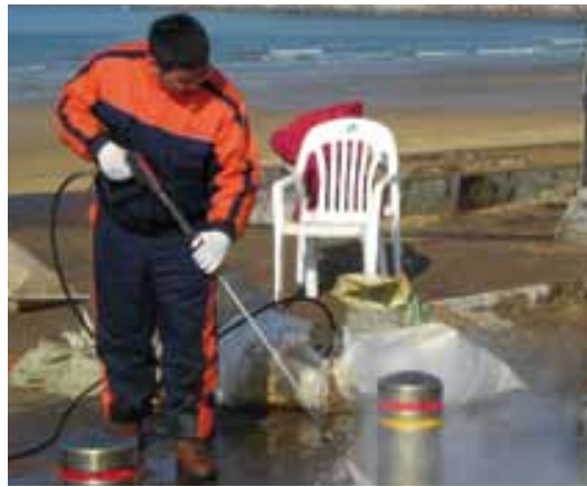
استخدام المياه المضغوطة في مرحلة التنظيف النهائية
