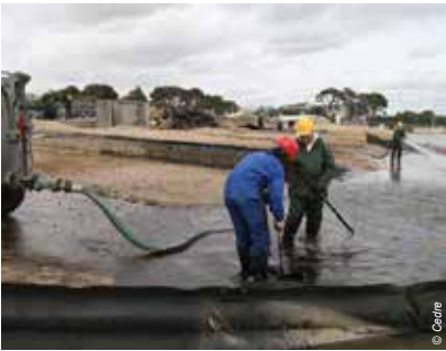
صورة توضح طريقة التخلص من التلوث النفطي باستخدام مضخة ماصة متصلة بشاحنة تفريغ
